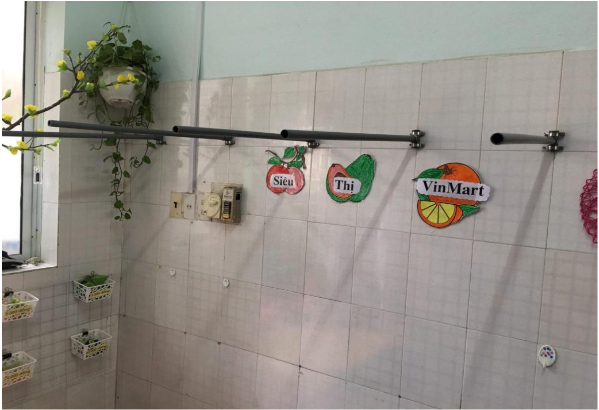
Lắp ống nhựa vào các ống T có trước tùy theo cách sử dụng dài- ngắn.
