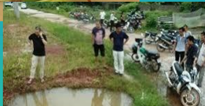
Hố sâu công trình chưa san lấp
