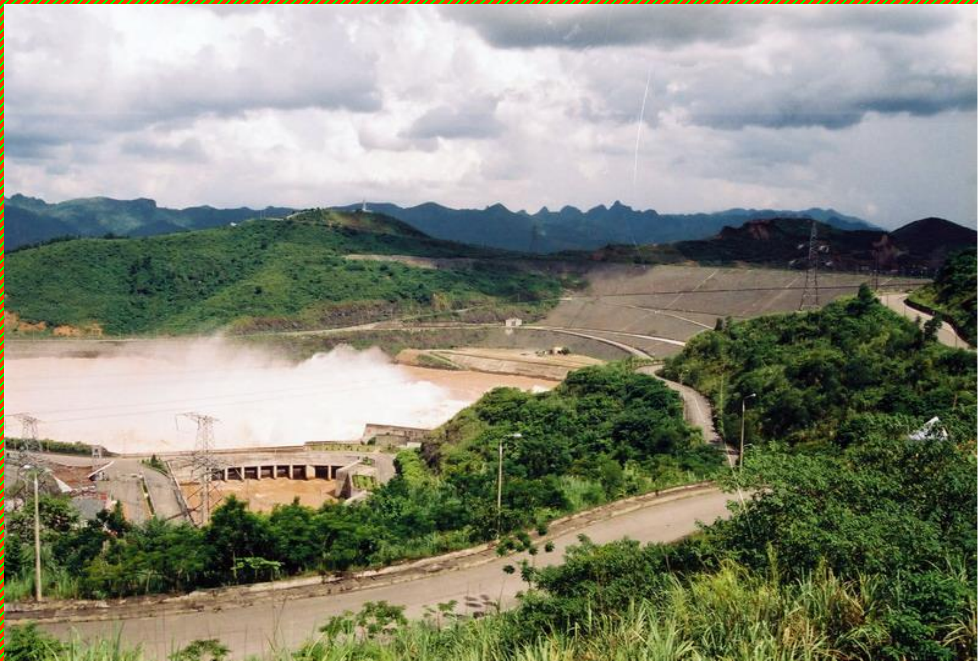
Toàn cảnh nhà máy thủy điện Hòa Bình khi đã hoàn thành
