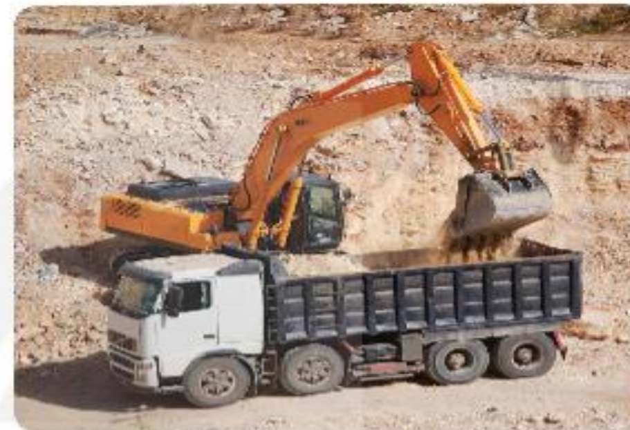
b) Máy xúc đất
