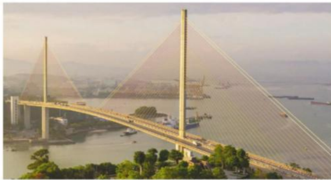
Cầu Bãi Cháy
