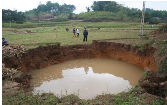
Hố chứa nước không có biển cảnh báo, không có rào chắn, không lấp sau khi sử dụng
